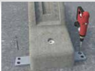
Staffa di ancoraggio per cemento armato
